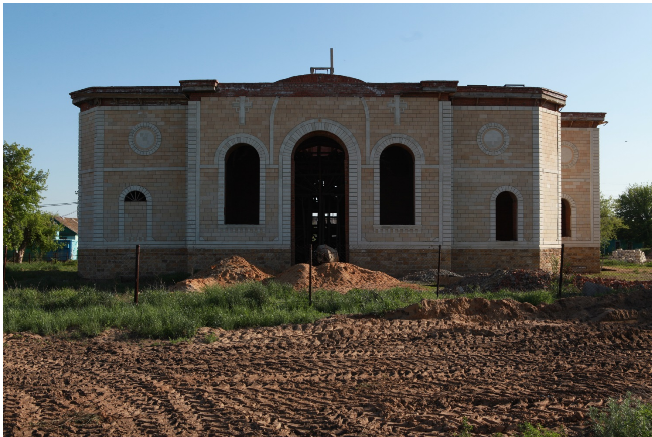
Фото 5.4 - Фасад в осях 7-1/Ж
