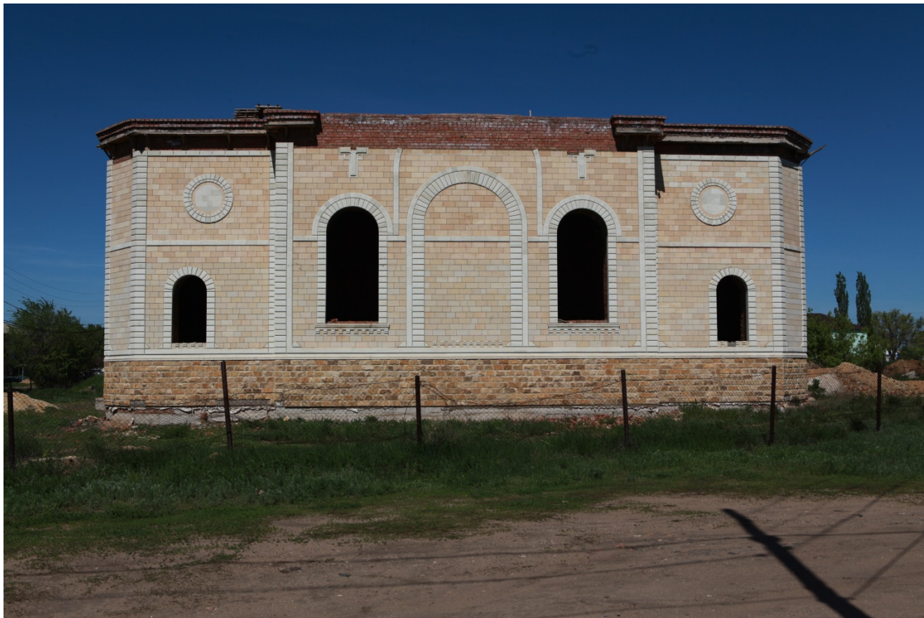
Фото 5.3 - Фасад в осях А-Ж/7
