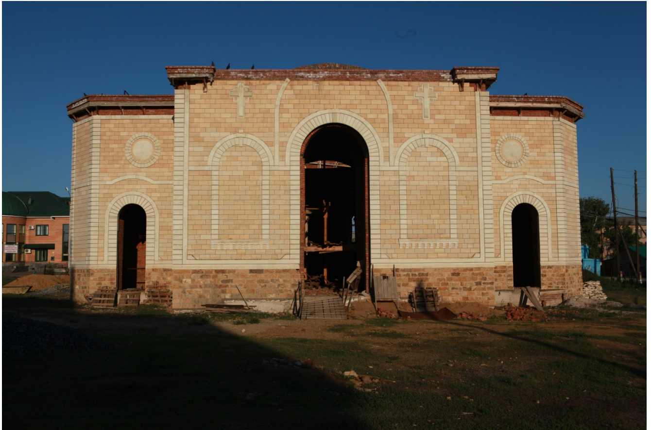
Фото 5.1 – Фасад в осях Ж-А/1
