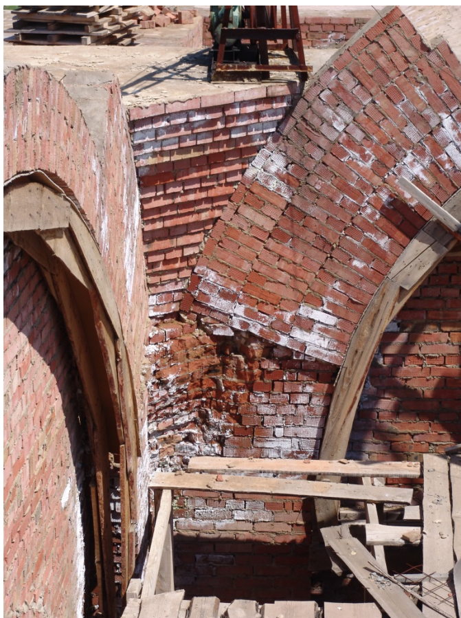
Фото 5.5 – Внутренняя стена в осях Д/З. Срублена часть кирпичной кладки в виду первоначального неверного устройства начала паруса
